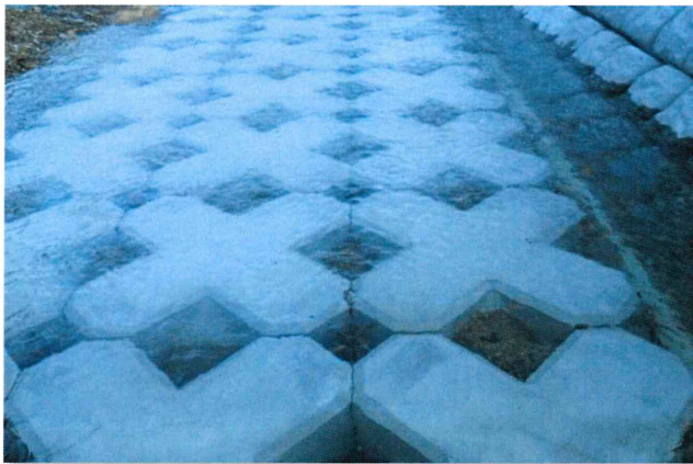
見坂川 0.5t 型・根固工／広島県 西部建設事務所
