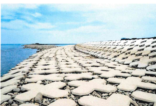
物部川 2t 型・護岸被覆工／国交省 高知河川国道事務所
