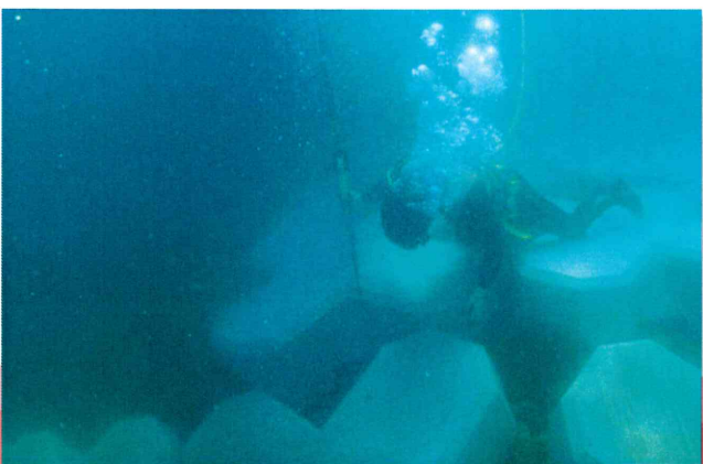
目井津漁港 2t 型・機能強化(被覆工)／宮崎県 油津港湾事務所
