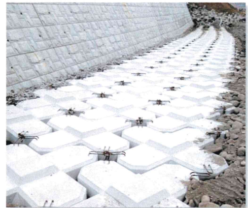
玖珠川 根固工 6t 突型 大分県 日田土木事務所
