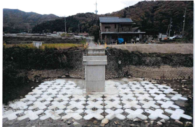
高大地橋 2t 型・橋脚根固工／広島県 安芸高田市役所
