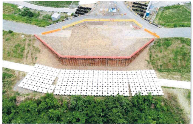
物部川 2t 型・橋脚根固工／国交省 土佐国道事務所
