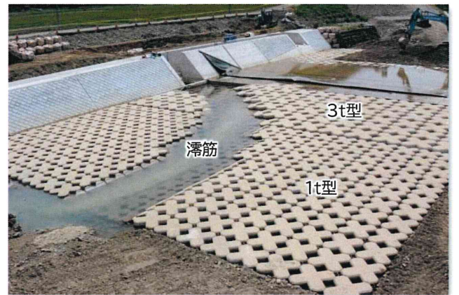
牧川 1,3t 型・護床工+魚道／京都府 中丹西土木事務所
