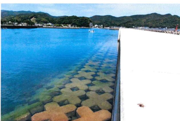
古江港 8t 型・機能強化(被覆工)／宮崎県 北部港湾事務所
