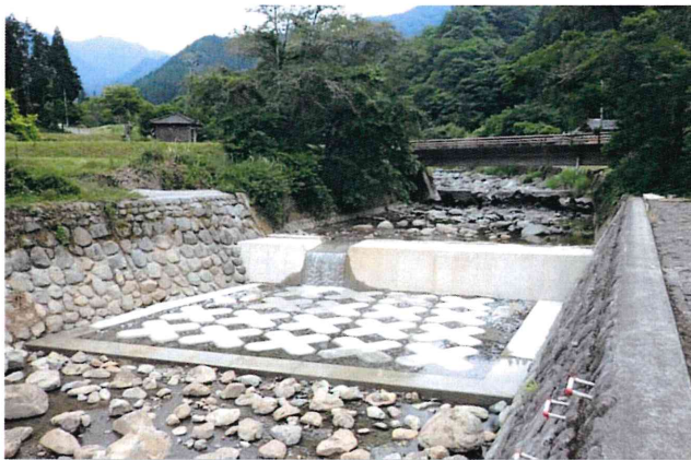
神原川 6t 型・護床工／大分県 竹田土木事務所
