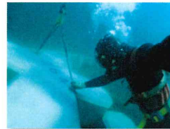
水中据付の様子
