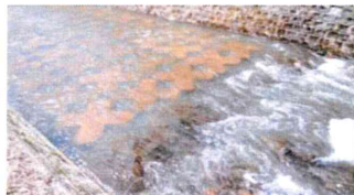
(左)北松木内川 根固工 4t 型 (右)厨川 護床工 2t 型:秋田県 仙北地域振興局
