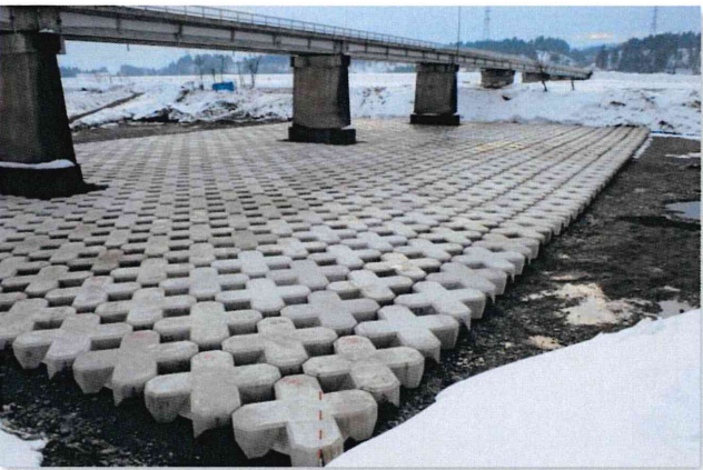
栄橋 8t 型・橋脚根固工／新潟県 十日町地域振興局
