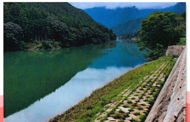
小森ダム 1t 型・護岸工／和歌山県 東牟婁振興局
