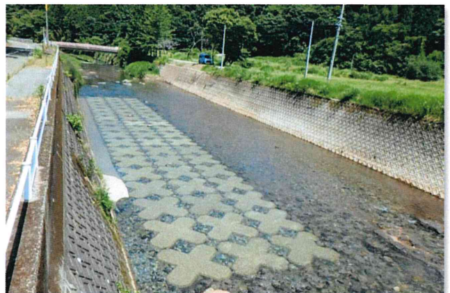
緒方川 4t 型・根固工／大分県 竹田土木事務所
