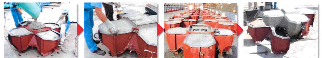
①打設～締固め
