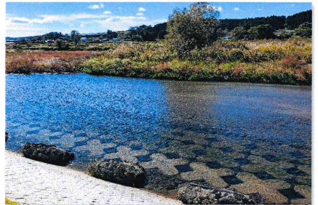
帯川 4t 型・根固工／栃木県 大田原土木事務所
