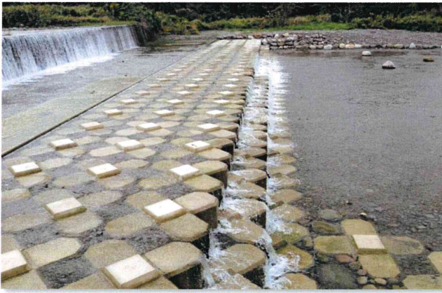
阿弥陀川 4t 型・護床工／鳥取県 西部総合事務所
