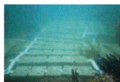
②海底設置状況
